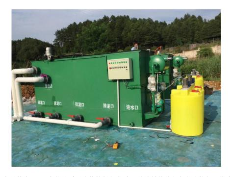
废水处理设备产品特点: 1、生化池采用生物接触氧化法,其填料的体积负荷比较低,微生物处于自身氧化阶断,产泥量少,只需三个月(90天)以上排一次泥(用粪车抽吸或脱水成泥饼外运)。2、该地埋式生活废水处理设备的除臭方式除采用常规高空排气,另配有土壤脱臭措施。3、整个设备处理系统配有全自动电气控制系统和设备故障报警系统,运行安全可靠,平时一般不需要专人管理,只需适时地对设备进行维护和保养。使用方法: 1、能够处理生活系统综合性废水及其相类似的有机废水; 2、采用具有耐腐蚀、抗老化等优良特性的不锈钢10年以上,碳钢20年以上,玻璃钢50年以上; 3、全套装置施工简单、操作容易,所有机械设备均为自动化控制,全部装置可设置于地表以下。
